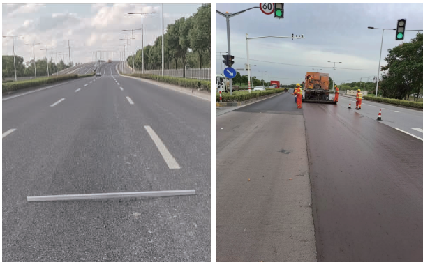
(a) (b) 图 3 含砂雾封层施工前后道路对比照片
