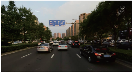
图 10 交叉口现状运行情况
