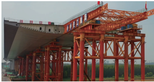
图4 施工现场临时墩布置图
