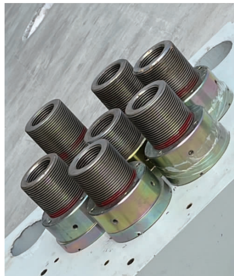
图 3 涂缓蚀剂锚头
