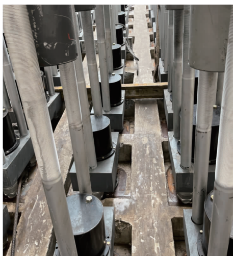
图8 龙门大桥锚固系统应用
