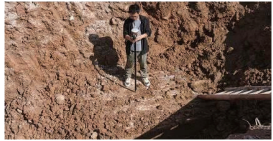
图8 盖板高程测量之实景
