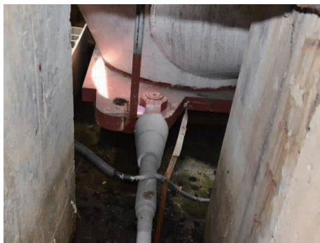
图5 拱脚横向拉杆实景照片
