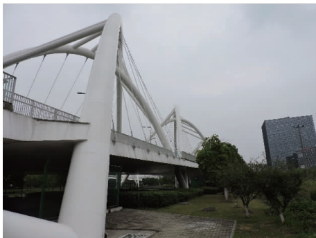
图4 主桥立面实景照片
