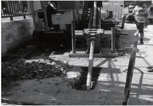
图2 定向钻先导施工
